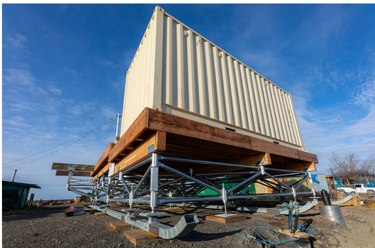
Figure 36. Des patins en acier placés au bas des fondations permettent de déplacer la maison (Rettig, 2023)
