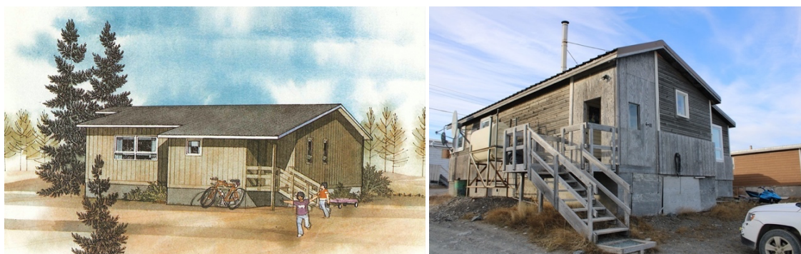
Figure 42. (À gauche) Le modèle HAP G avec 4 chambres sur 1 étage. (À droite) Une maison issue du programme HAP, construite dans les années 80 (Venn, 2023b)
